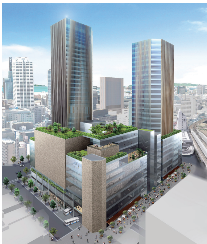
北東から見る建物外観
