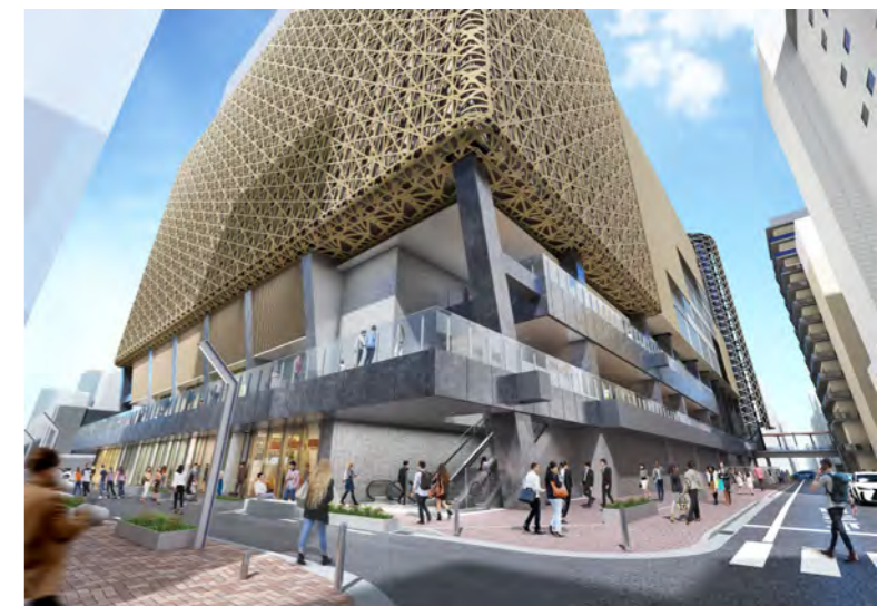
建物外観 (建物北西から望む) あじさい通りに面して路面店や歩行者デッキを配置し、低層部の北側外壁は、竹籠をモチーフにした2重の外装デザインで構成
